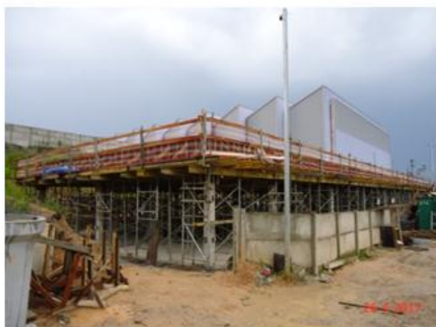
Bloco E: Laje de cobertura em execução.
