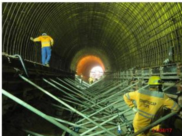
Túnel de estacionamento Via 2: Execução do revestimento secundário
