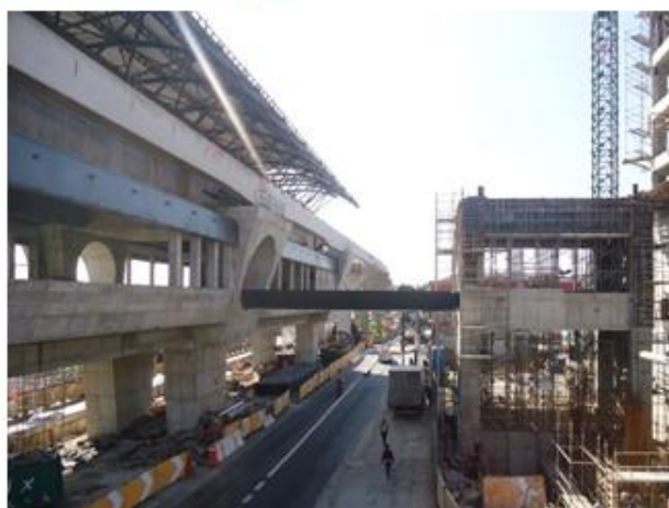
Instalação do passadiço metálico, das telhas da cobertura metálica e da base da passarela do Acesso.
