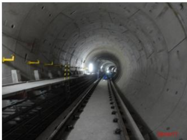
Trecho Campo Belo – VSE Jesuíno Maciel: Instalação do corrimão na passarela de emergência
