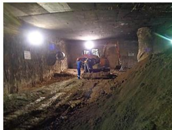
Escavação do acesso de interligação com a Linha 5.
