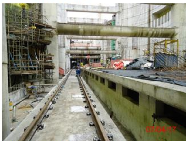
Corpo da estação: Revestimento secundário e plataforma – Poço 5
