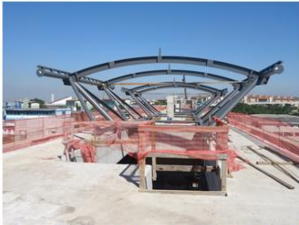
Instalação da estrutura metálica da cobertura da Plataforma.
