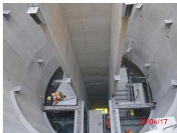
Edifício de salas técnicas: Estruturas internas do poço do edifício das salas técnicas
