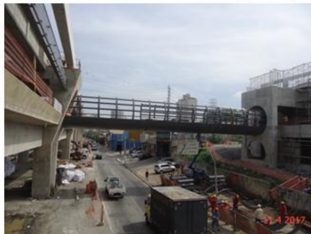
Instalação da estrutura metálica da passarela.
