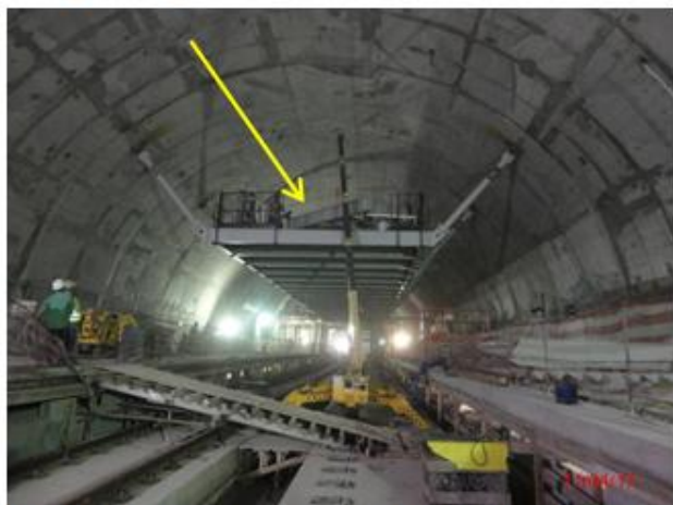
Corpo da estação: Mezanino metálico montado
