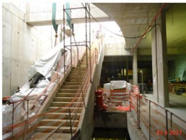
Acesso Principal: Instalação da escada rolante
