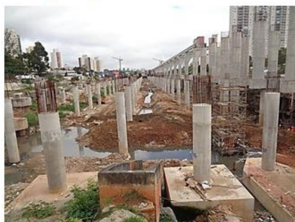
Pátio Água Espraiada – Execução de blocos e pilares.
