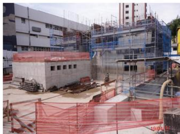
Execução da torre de ventilação e saída de emergência
