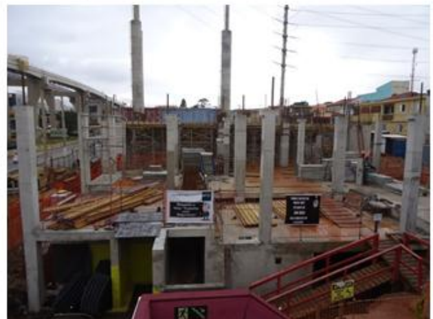
Execução do cimbramento da primeira laje da sala de alta tensão.
