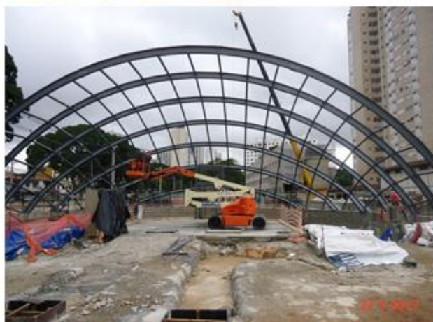
Acesso Principal: Montagem da estrutura metálica da cobertura
