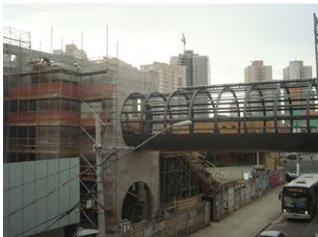
Instalação da estrutura metálica da passarela.
