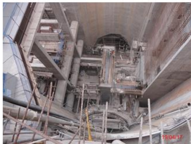
Acesso Principal: Execução das estruturas internas do Poço 1
